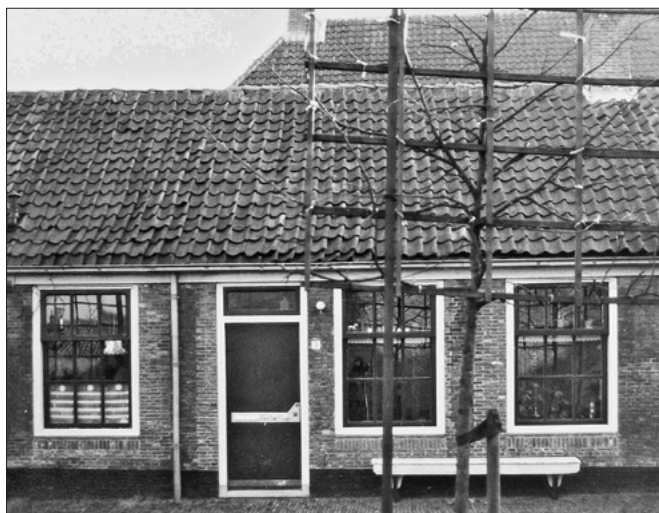
Zuiderdorpstraat 9 kort na de restauratie, ook hier zijn duidelijk de verbouwingssporen in het metselwerk te zien.
