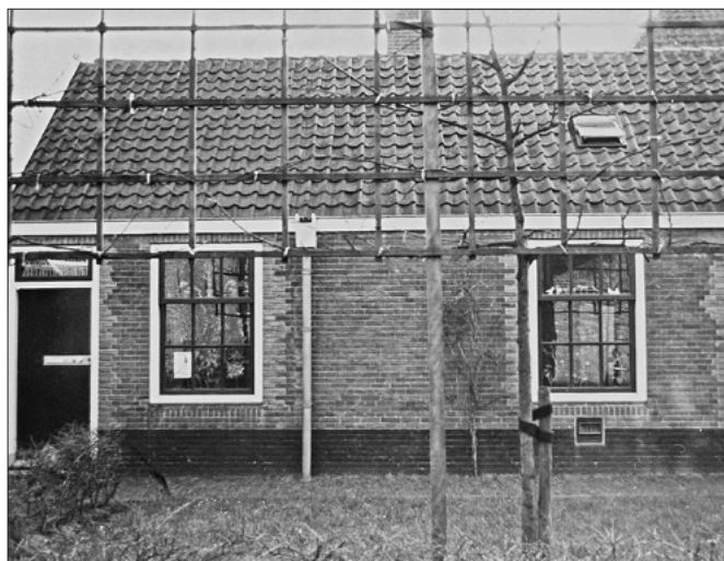
Zuiderdorpstraat 7 kort na de restauratie, duidelijk zijn de verbouwingssporen in het metselwerk te zien.
