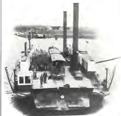
De Velservoer stoompont ± 1910. Ten behoeve van de stoomtramweg Haarlem-Alkmaar waren de ponten tevens ingericht voor het overzetten van een trein van ± 30 meter lengte.
